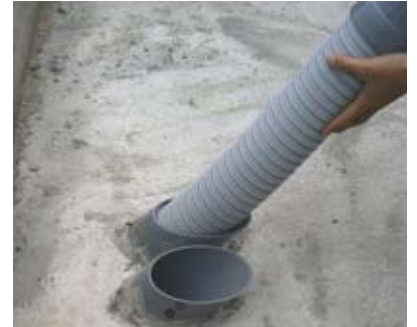
基礎貫通キット施工例（配管の更新が可能）
